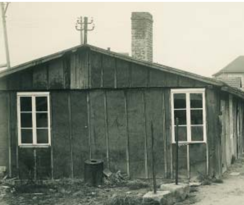
Das erste Produktionsgebäude in Oberderdingen
