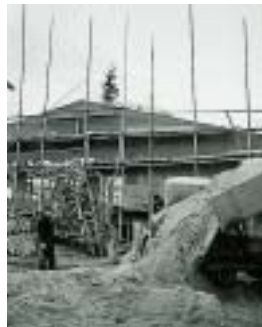
Der Ausbau des Zweigwerkes Sulzfeld
