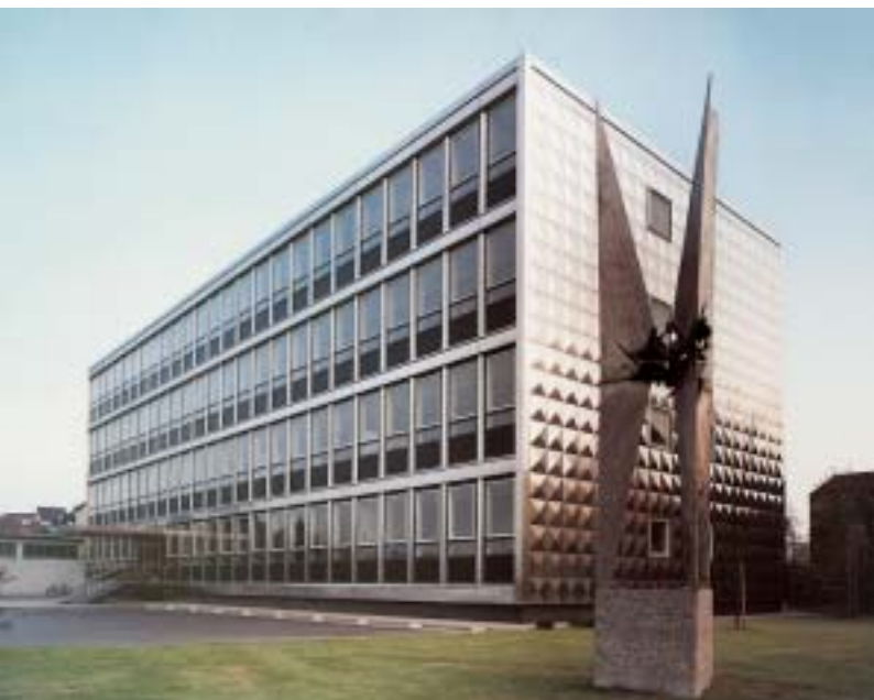
Das neue Verwaltungsgebäude
