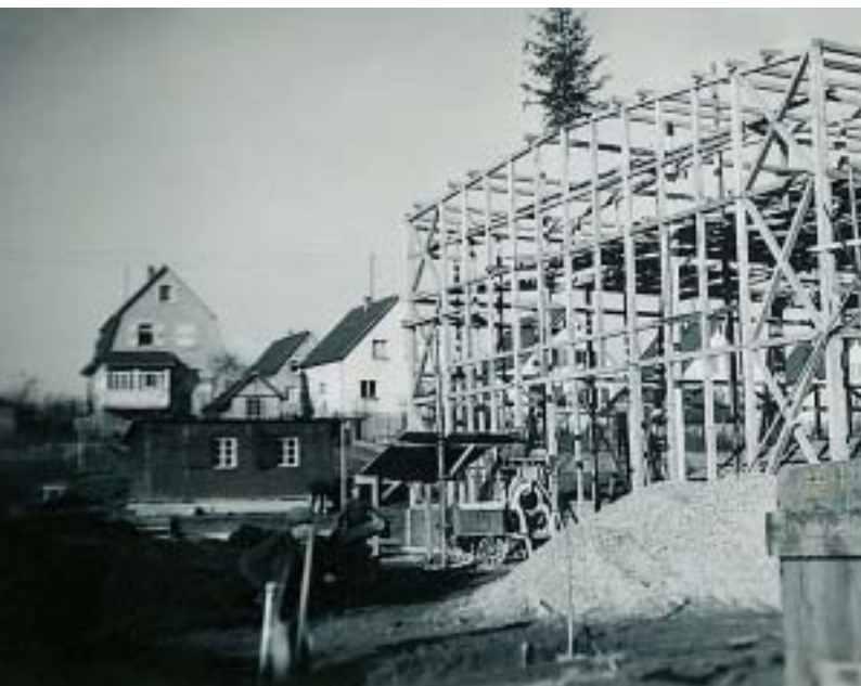
Der Rohbau für die große Pressenhalle
